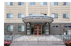
片倉福岡シルバーマンション (ケアポート箱崎) 福岡県福岡市
